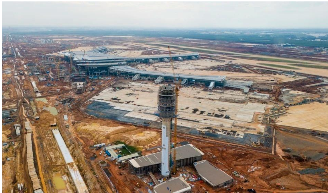
Công trường dự án Long Thành đầu tháng 11 – Nguồn Tạp chí Tri thức
