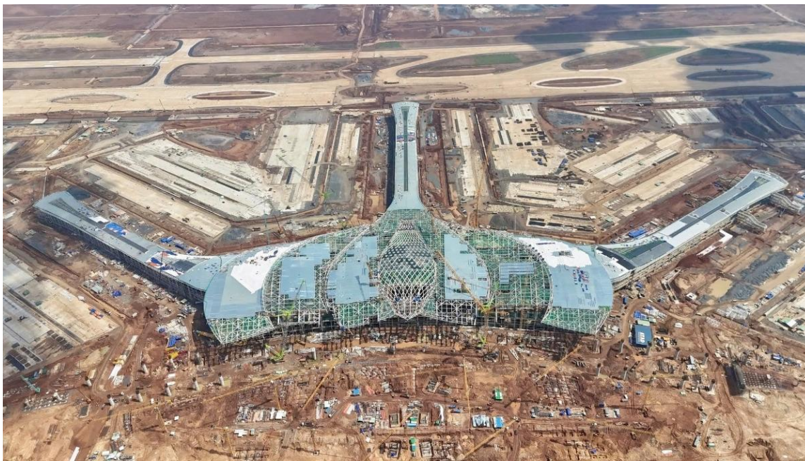
Nguồn: Công trường thi công cảng HKQT Long Thành
